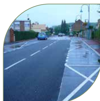
Chaussée à structure réservoir avec enrobés poreux à Douai (59)
