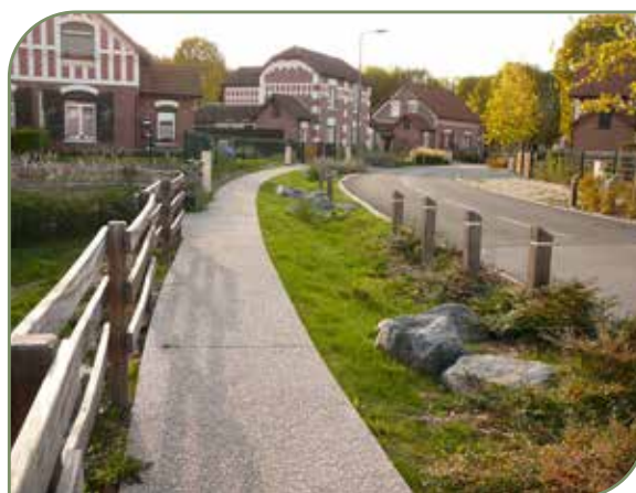
Noues et revêtements perméables - Ancienne cité Bruno à Dourges (62)
