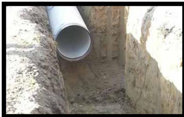
Tranchée ouverte pour pose de réseau d'eau potable
