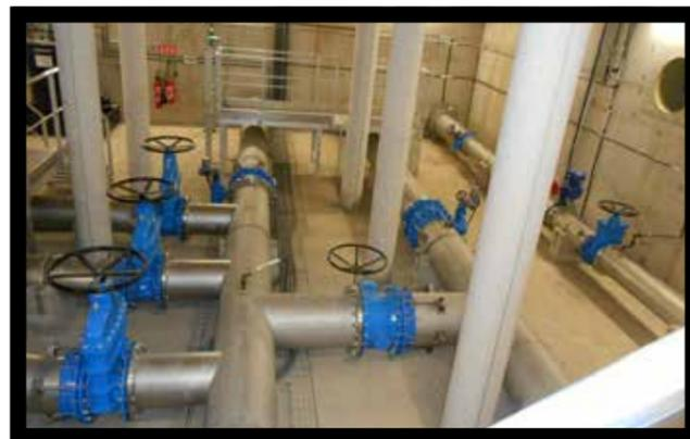
Vannes et tuyaux dans une station de pompage
